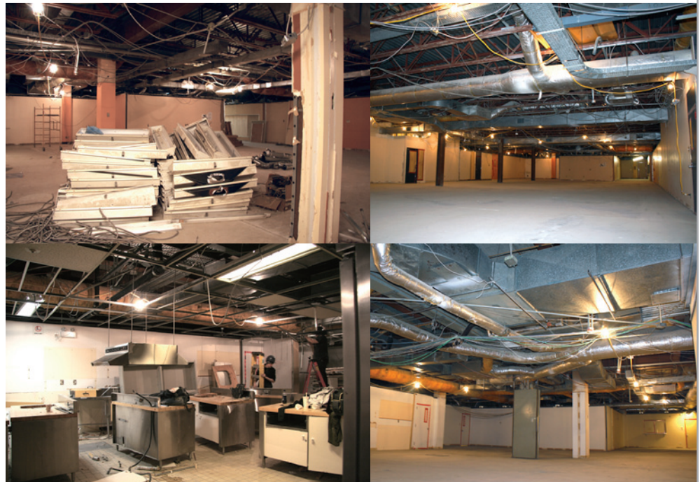
Sur les photos à gauche, les locaux du secteur de l'ancienne imprimerie, du développement pédagogique et des labs de diététique pendant la démolition. Les photos à droite témoignent de l'état actuel des travaux dans les mêmes secteurs.
