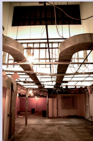
◀ Une vue de l'espace récupéré à la suite de la démolition du plafond des locaux de l'UQÀM Laval.
