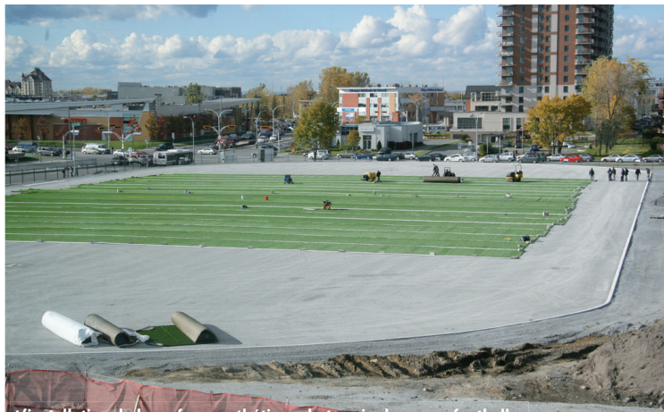
L'installation de la surface synthétique du terrain de soccer-football
