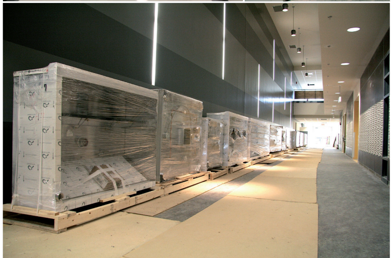
Les immenses hottes du département de Techniques de diététique en attente de leur installation
