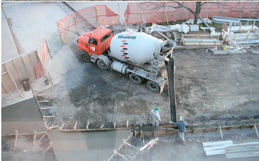
En haut, le nouveau parement métallique extérieur En bas, la préparation des bordures et trottoirs
