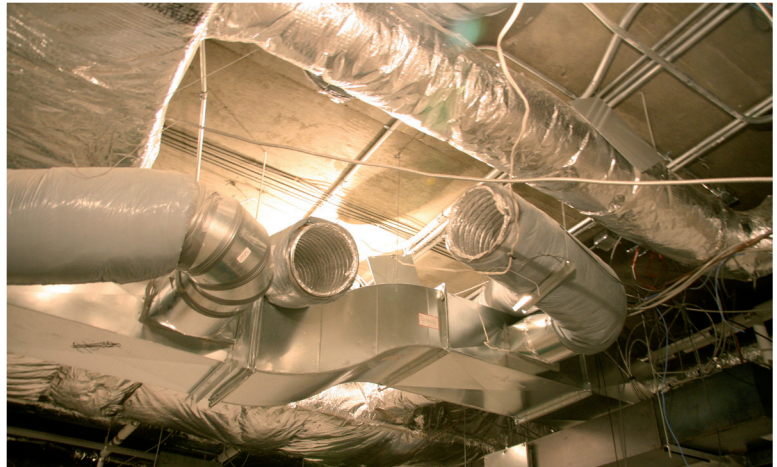
Les conduites d'évacuation des hottes dans le nouveau secteur de Techniques de diététique
