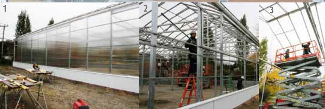
1- Les murs de la serre sont en polycarbonate. 2- Des panneaux ouvrants installés sur le toit assureront la ventilation de la serre pendant la période estivale. 3- Les ouvriers préparent la structure de la serre pour recevoir le recouvrement rigide.
