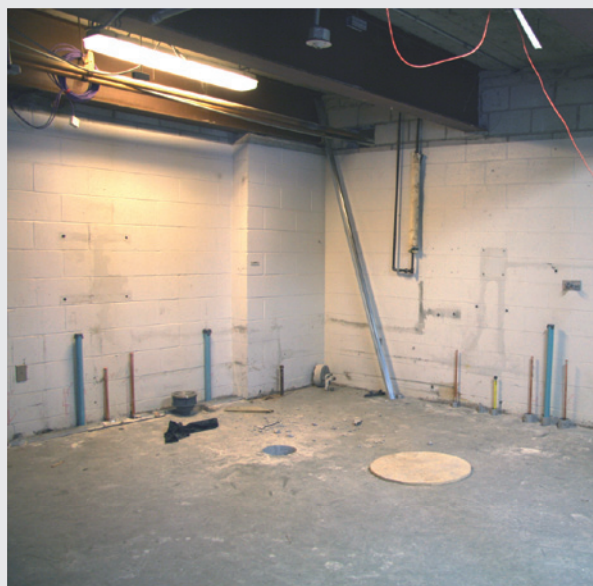
Travaux de démolition du laboratoire
